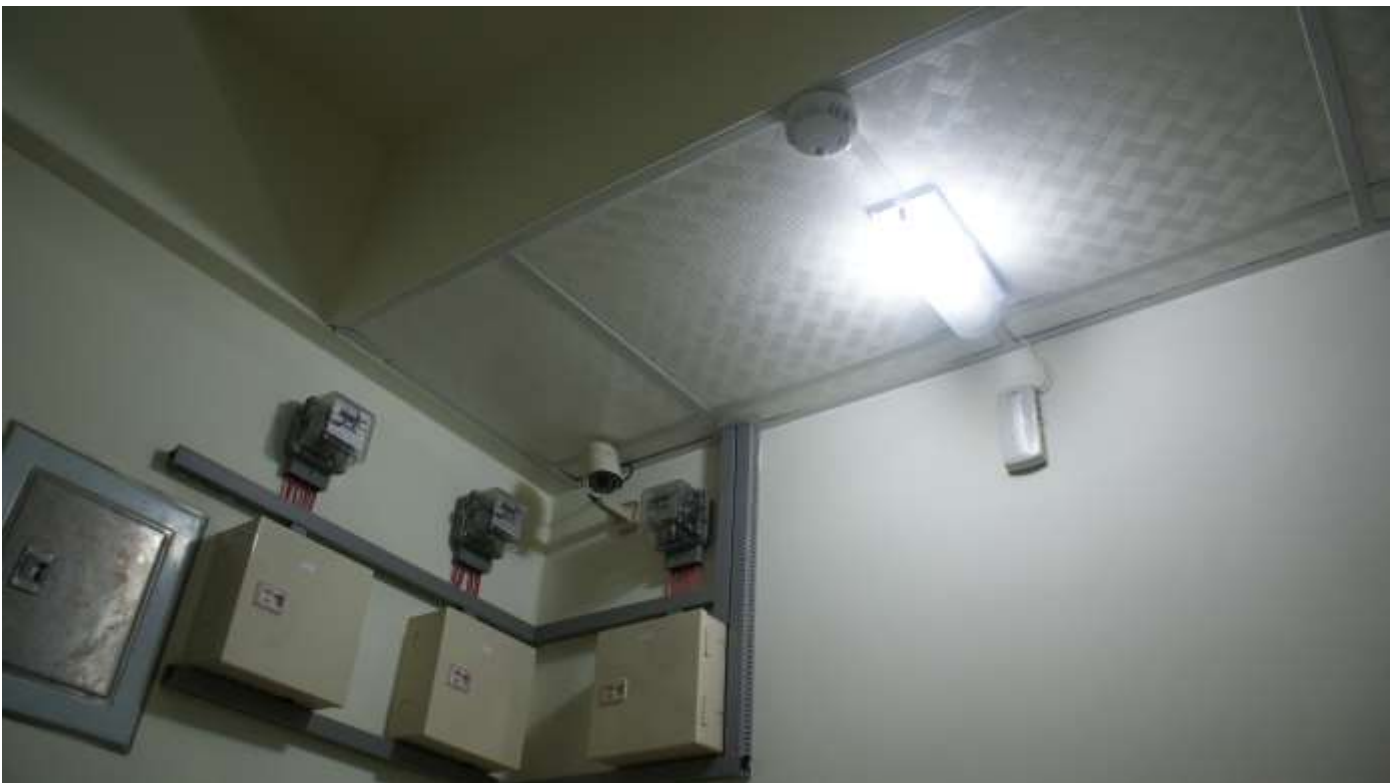
獨立式電表、攝影機、緊急照明設施及火警警報器
